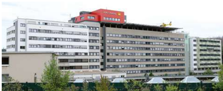
Die Technik muss laufen – sonst steht der Krankenhaus-Betrieb still.
